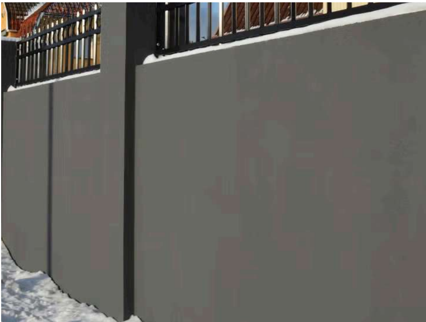
För en anläggning som den här muren krävs alltid bygglov, enligt Eksjö kommun. Bild: Mari Ermeland
