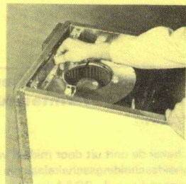
6. Lossa vingmuttrarna som håller tilluftsfälkten.
