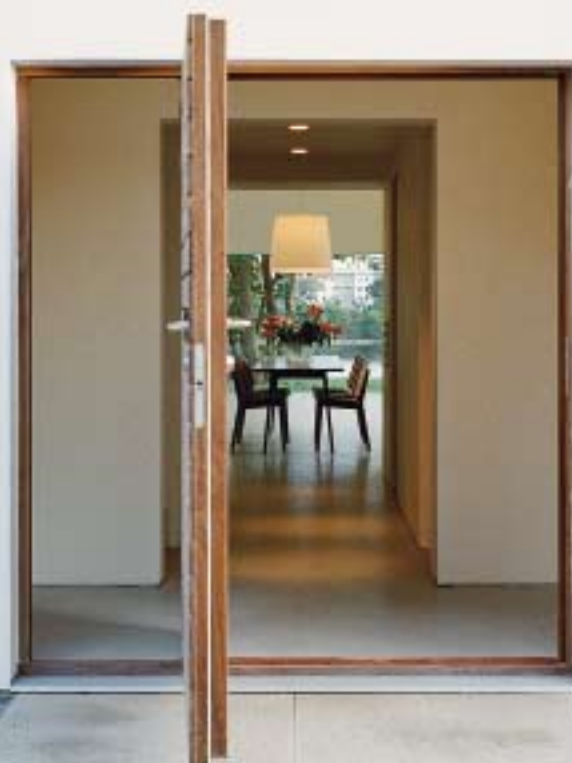
Fasaden sluter sig mot norr. En pivotdörr i valnöt, »en riktig ladugårdsdörr«, öppnas mot kök och vardagsrum.
