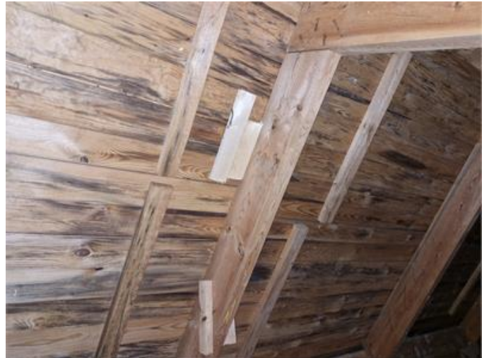
Delar av underlagstak på vinden
