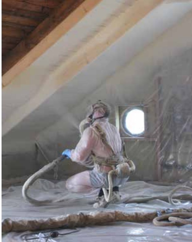
Polyuretansprayning ger en homogen isolering utan köldbryggor.
