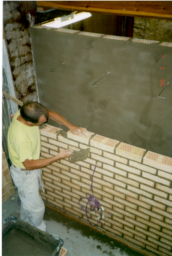
Bild 1. Provmuren byggs upp
