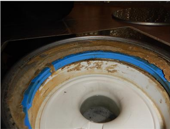
Dusch/Bad/Wc: Tätskiktet är felaktigt ansluten i golvbrunnarna, synlig under klämringen. Klämring i duschens golvbrunn är inte i sitt nedersta läge.
