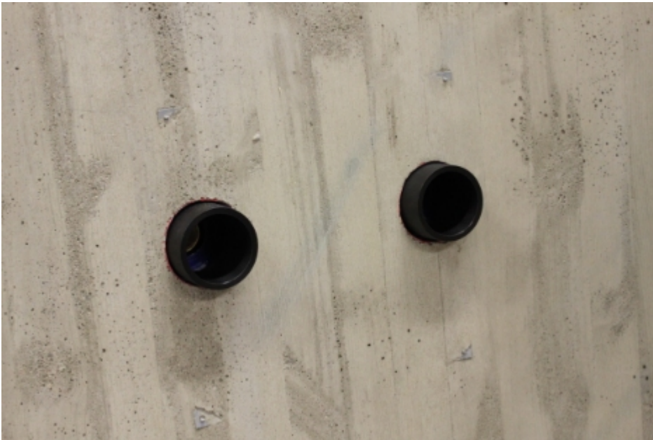
LK Väggdosa UNI 16 med LK Förlängningshylsa UNI monterad.
