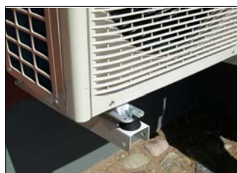
18. Häng upp utedelen. Fixera de främre dämparna så att ni kan passa in de bakre dämparna i maskinens djupled.
