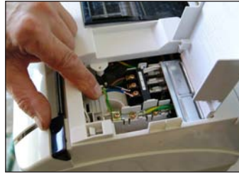
6. Montera en 4-ledad, 1,5 kvadrat strömkabel. Jord till jord. 1=brun, 2=svart, 3=blå. Strömkabeln går sedan vidare till utedelen.
