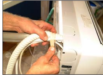
7. Tejpa ihop rör - och strömkablar. Då blir det enklare att föra paketet genom det borrarade hålet.
