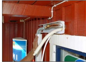
26. Nu är rören kopplade och då går vi vidare med rören till utedelen.
