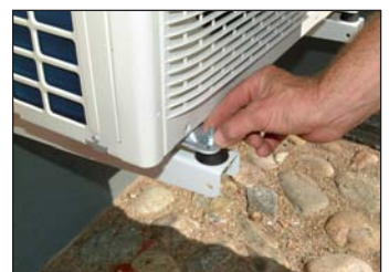
20. Skruva fast utedelen och drag åt. Ej för hårt! Då kanske ni skadar gummit i dämparna.
