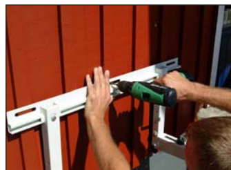
15. Sätt upp konsollen. Borra hålet för mittskruven.
