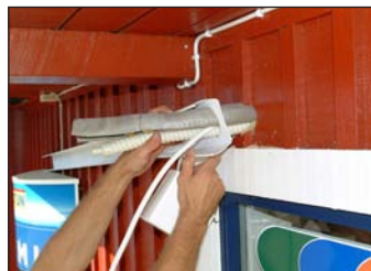
10. Plastkanaler monterar ni som vi gör. Se våra kommande bilder.
