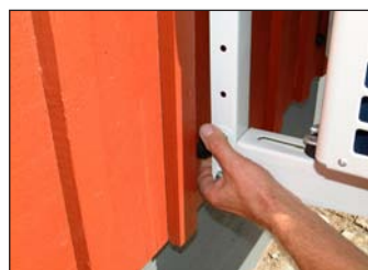
19. Justera gummi/skruvarna på konsollens baksida.
