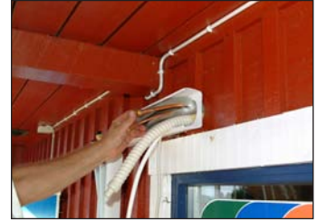
24. Böj försiktigt rören så att de kommer rätt i längdriktningen.
