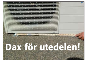
12. Montera er konsoll enligt bifogad beskrivning. Mät därefter ut cc mellan utedelens fötter.
