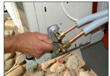
36. Släpp på gasen med sexkantsnyckel 4. Öppna kranarna för fullt.
