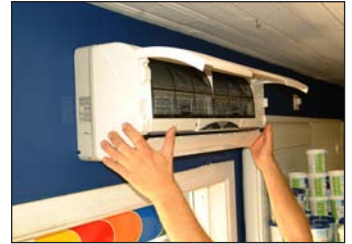
8. För ut rör-och strömkabelpaketet genom hålet och häng upp inledelsen. Nu är den på plats!
