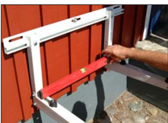
17. Väg in konsollen med vattenpass. Borra och skruva därefter fast de två andra fästskruvarna.
