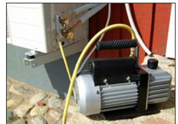
32. Vacuumsug under en timme. OBS! Koppla av slangen vid värmepumpen när vacuum-pumpen fortfarande går efter en timma! (Då kan ni inte få baksug!)
