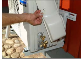
22. Tag av skyddspanelen till el- och gaskopplingarna.
