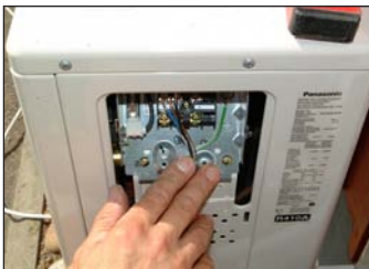
33. Montera strömkablarna som kommer från inledelen enligt ruta 6. Jord till jord. 1=brun, 2=svart, 3=blå. Skruva tillbaka plåten.
