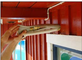
9. Här ser ni hur rör - och strömkabelpaketet kommer ut genom det borrarade hålet.
