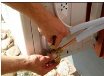
37. Skruva tillbaka muttrarna för vätskerören.
