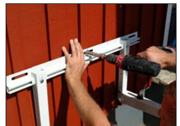
16. Skruva fast mittskruven. Använd lämpliga fästskruvar när ni monterar er konsoll.
