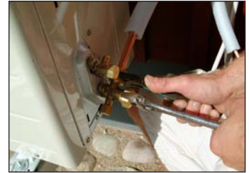
28. Fäst rören i utedelen. OBS! Drag åt ordentligt se ruta 25. Håll emot med nyckel, annars stor risk att knäcka anslutningar!
