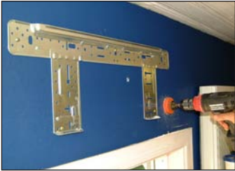
5. Borra hål i väggen. 65-70 mm. Obs! Borra hålet med lite fall mot utsidan pga att dräneringsslangens vattenflöde
