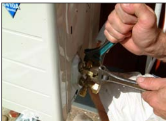
29. Vi visar även i denna bild hur ni måste hålla emot för att inte knäcka hela anslutningspaketet! Mycket viktigt!
