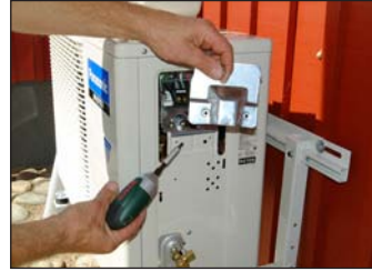
23. Tag av plåten som sitter framför elkopplingarna. Vänta med att installera. Det kommer under bildruta 33.
