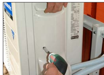
38. Skruva tillbaka skyddspanelen till el- och gaskopplingarna. Nu är det färdigt och dax att gå in och köra igång värmepumpen!
