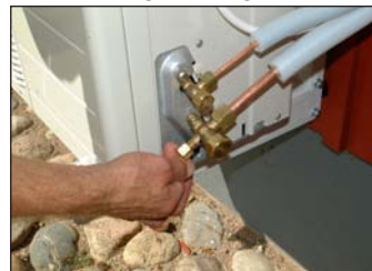
35. Skruva fast mutter till vacuum-pumpssugningsröret.
