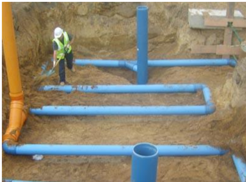
Figur 6. Installation av Rehaus markkanaler (Brinkley, 2009)
