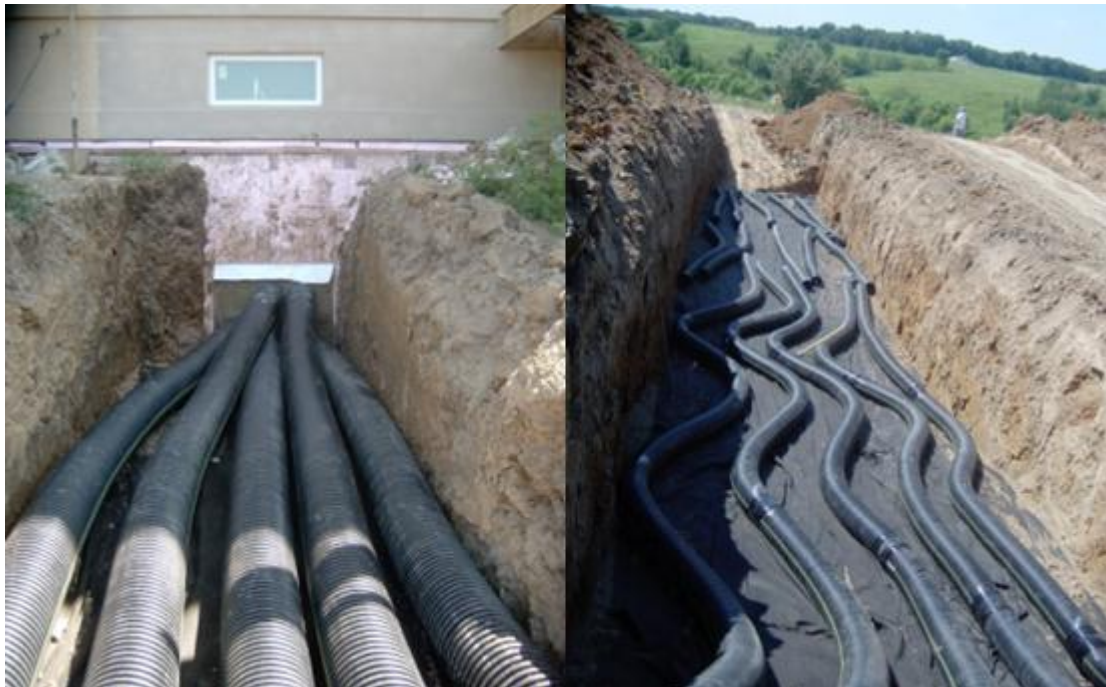
Figur 8. Installation av markkanaler (Larson, 2009)
