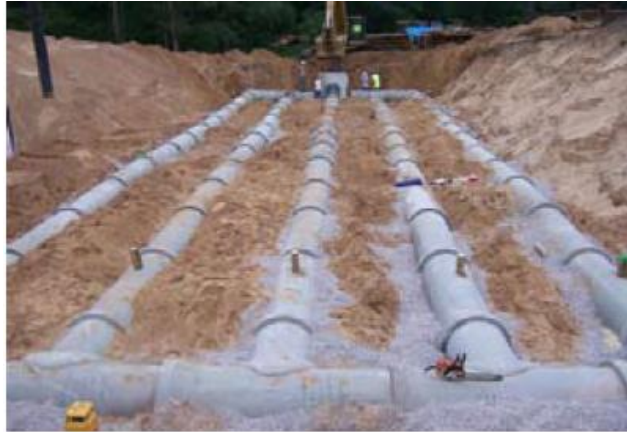
Figur 7. Aldo Leopold Legacy Centers byggnation av markkanaler. (Aldo Leopold, 2006)
