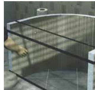
Armera hela insidan med armeringsväv ARM-600.
