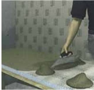
För fixering av önskade former används fastmassa COL-AK och armeringsväv ARM-600.
