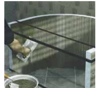
Spackla med fastmassa COL-AK över armeringsväv ARM-600 och låt torka. Klart för beläggning.
