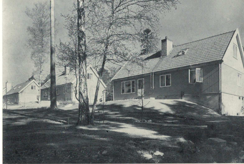
Friliggande hus i 1 1/2 plan, med källare, byggda i ett antal av 26 på Lidingö 1957. Varje fastighet omfattar 144 m 2 bostadsyta (inkl. bostadsutrymmen på vind) med sex rum, hall, kök, badrum, toalett samt tvättrum, pannrum och garage. Arkitekt: Karl Schollin, Stockholm.
