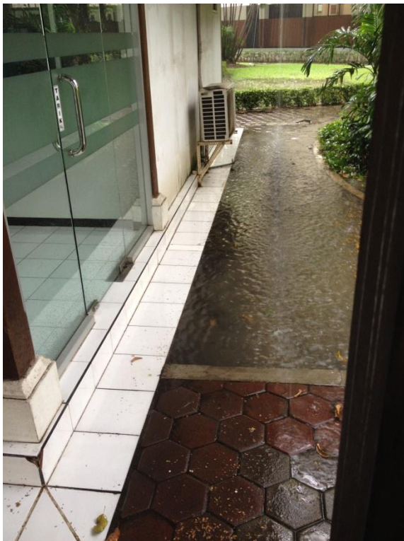
Figur 7 Vattenansamling runt hus efter regn (Granberg, 2015)
