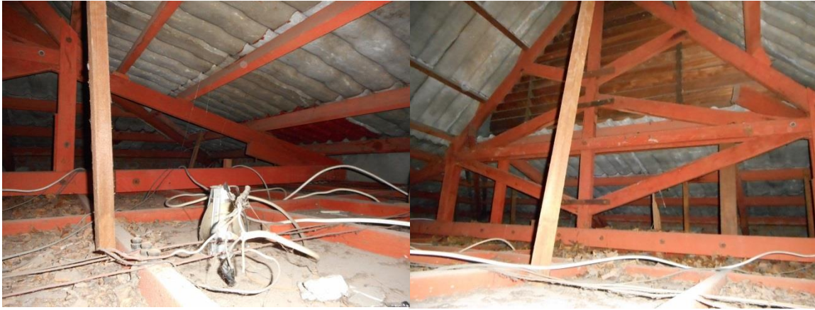
Figur 22 Fackverkskonstruktion i vindsutrymme (Granberg, 2015).
