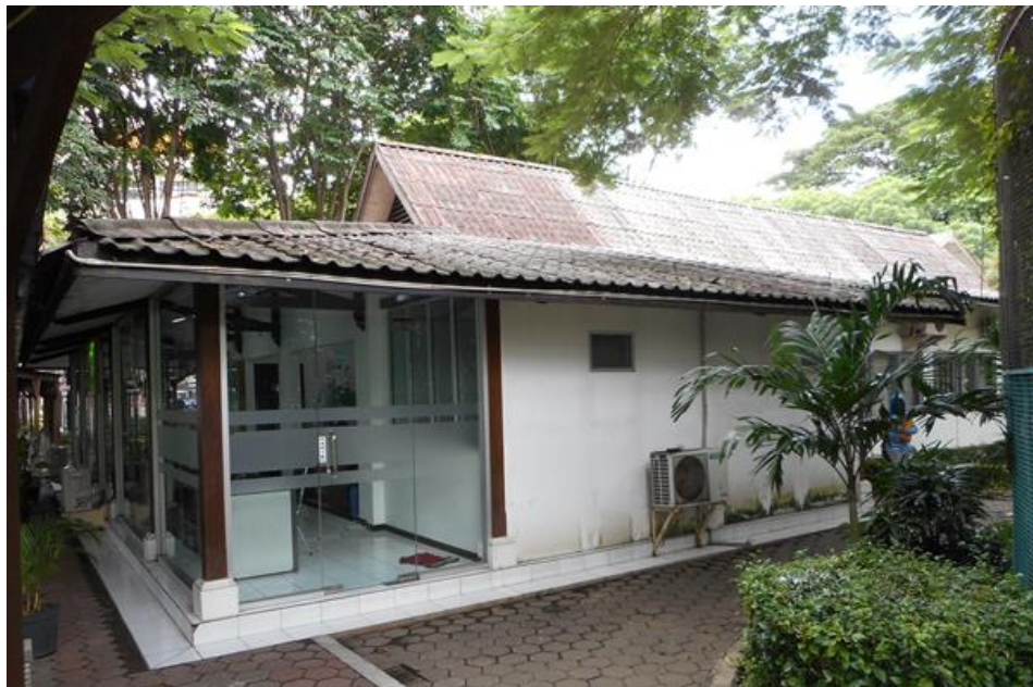
Figur 15 Byggnadens framsida i västlig riktning (Gustafsson, 2015).
