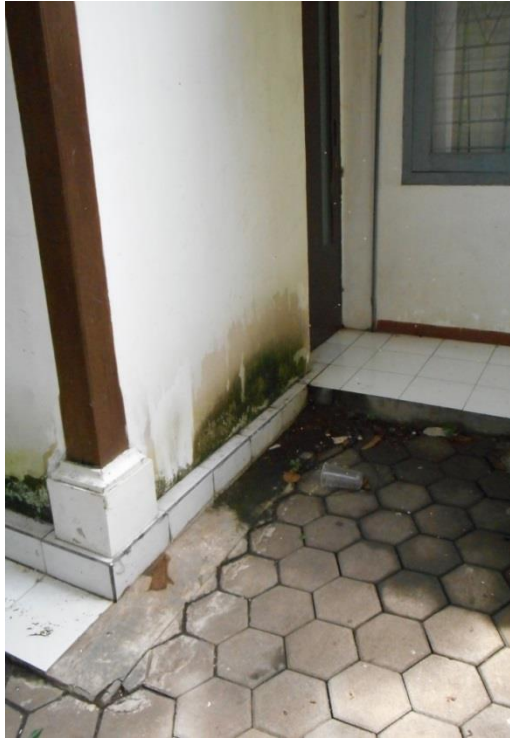
Figur 25 Mikrobiell påväxt på fasad (Granberg, 2015).
