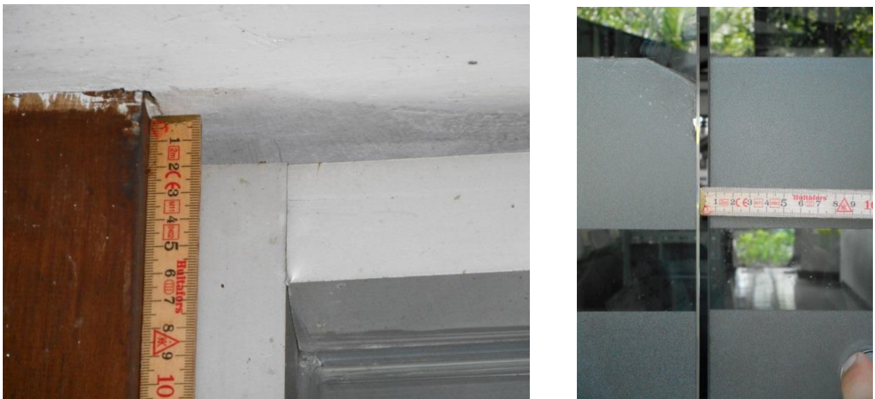
Figur 27 Otäthet mellan glasparti och tak samt springa mellan dörr och glasparti, läckagepunkt C (Gustafsson, 2015).
