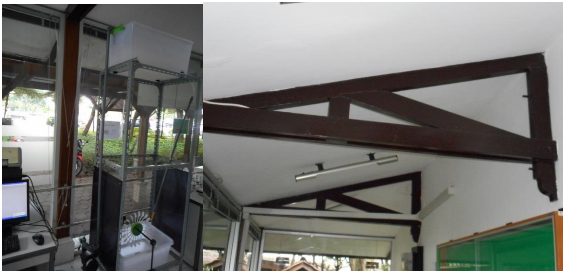
Figur 21 Takstol för tak runt byggnaden (Granberg, 2015).
