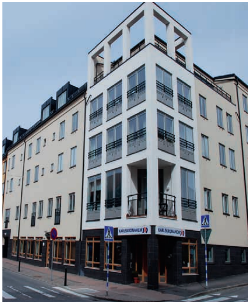
Bygget av Kv. Adlersten kom att bli ett mycket lyckat exempel på en byggherre i centrum. Trots svåra förhållanden hamnade det ekonomiska slutresultatet 20 procent under kalkylen.
