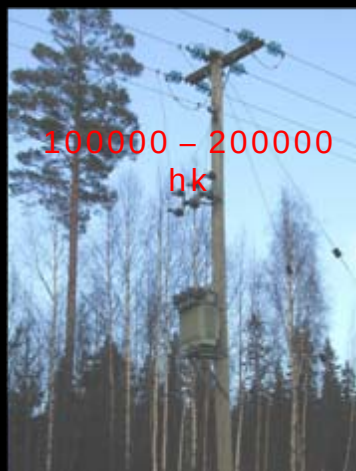
KRAFTLEDNING 12kV med stolptrafo 12/0,4kV
