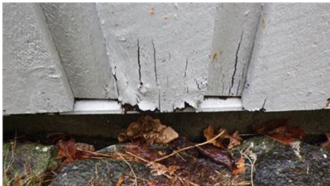
Rötskadad fasadpanel
