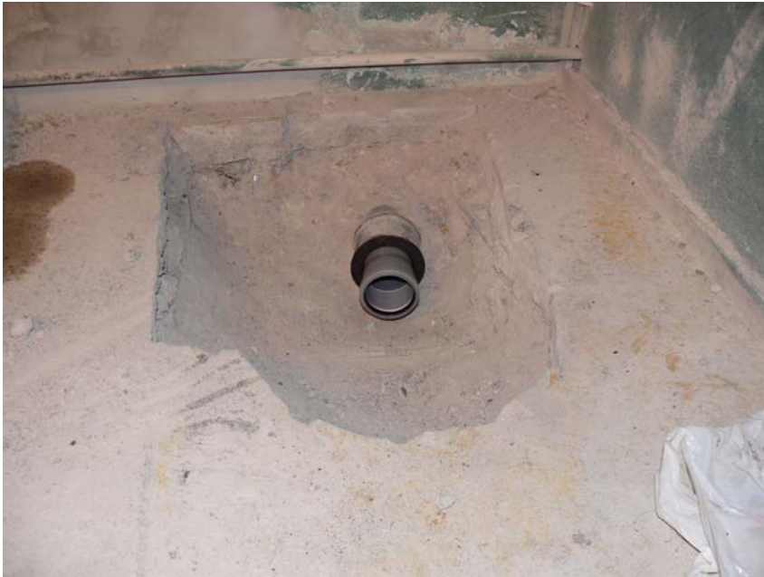
Figure 3 Nytt 75 mm plaströr anslutet till gjutjärnsböj med ny gumminippel 96x75.
