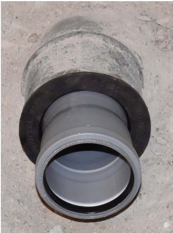
Figure 4 Nytt 75 mm plaströr anslutet till gjutjärnsböj med ny gumminippel 96x75 (Närbild).
