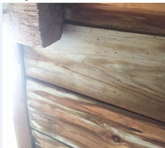
15. Missärgningar i råsponten runt/under takfönster, träet kändes dock torrt och fint. Otätheter takfönster?
