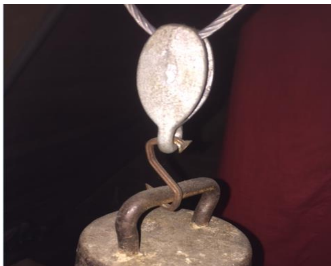
19. Härlig lösning för hjälp vid stängning av lucka till vindsstege.
