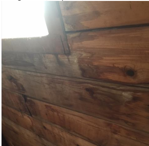
15. Missärgningar i råsponten runt/under takfönster, träet kändes dock torrt och fint. Otätheter takfönster?
