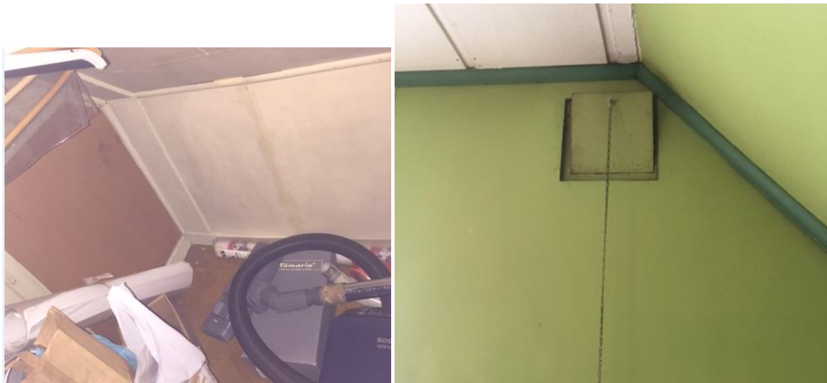
4. Rummen intill badrummet på ovanvåningen, kunde inte direkt se några tecken på fuktskador i väggar eller golv i dessa. Ventilen på bild två är ut mot yttervägg (alltså inte ventilen från badrummet). Klädkammare på vänstra bilden och mini-sovrum på den högra.
